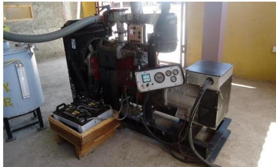
**Figura 4. Unidad generadora de electricidad**
