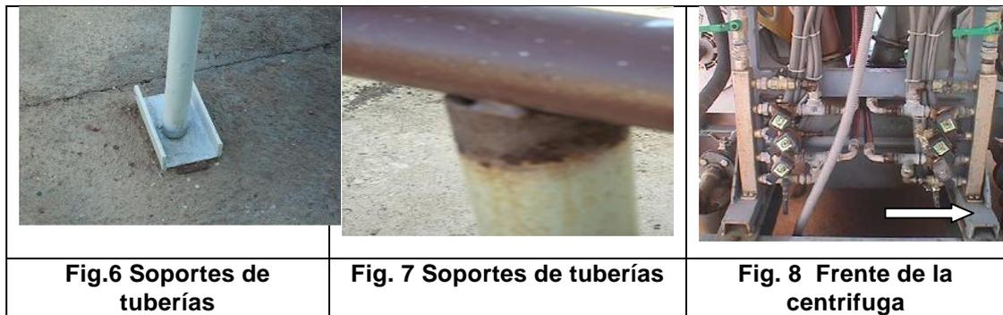
El diseño apropiado, la selección de materiales y las formas geométricas óptimas constituyen elementos de gran importancia en la durabilidad de las estructuras, determinando que se prolongue o no su vida útil; puesto que puede evitar o disminuir la ocurrencia de muchas formas de corrosión /4/.
