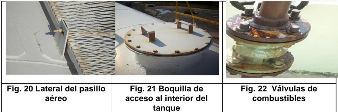
Del análisis realizado, se observa la gran incidencia que tienen los problemas de diseño sobre los problemas de corrosión que se presentan en el área de combustibles y que son causa fundamental de su deterioro.
