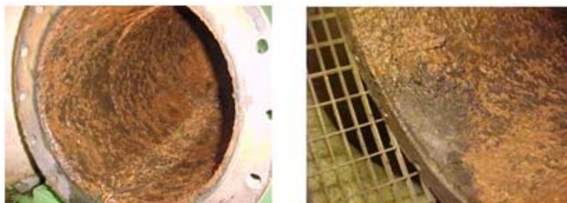
Fig. 1 Aspecto del interior de las tuberías conductoras de agua.
