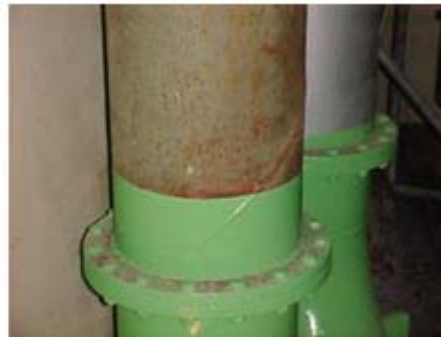
Fig. 3 Aspecto exterior de tuberías afectadas por la corrosión.
