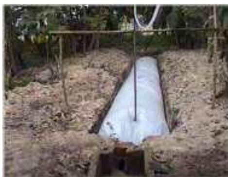
**Biodigestor de polietileno**
