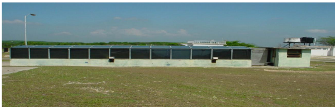
Fig. 1- Secador solar multipropósito de 12 m 3 de capacidad
